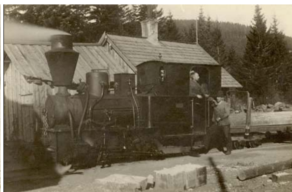
Lok Nr.2 beim Heizhaus, Feistritzsattel
