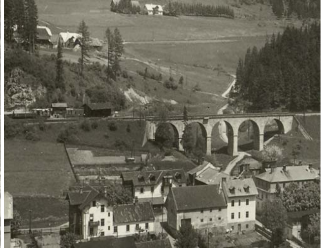
Steinhaus am Semmering, Südbahnviadukt
