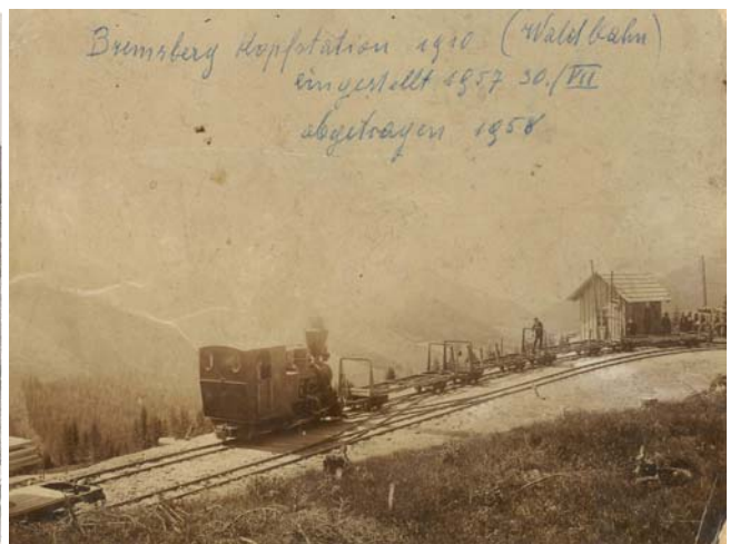
Bremsberg Bergstation, Sattelstrecke
